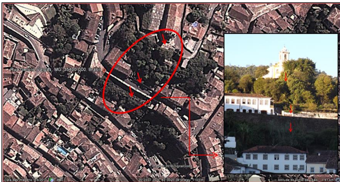
Figura 3 – Locais dos tubos de inclinômetro instalados nas imediações da Igreja São José e da Rua Getúlio Vargas. (Fonte: Google Earth, acessado em 10/04/2014)
