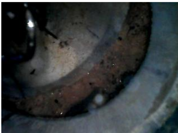
Figura 3. Vista para descontinuidade do duto do piezômetro. (Neves, 2017)
